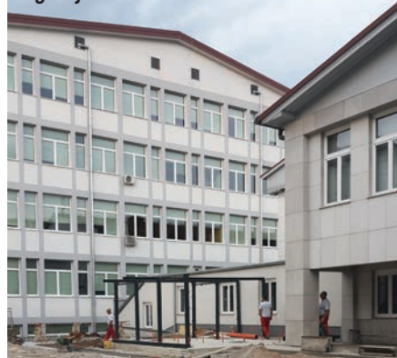
Ogrodje nove kolesarnice
